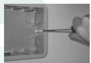
8. Enyesar la pared. Si la solapa de la caja queda enrasada, insertar las pinzas de nivel.
